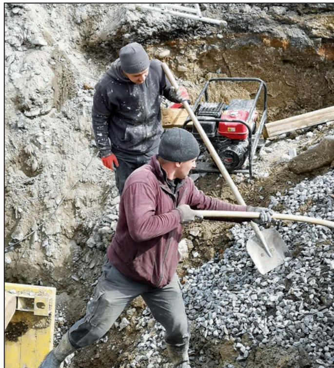
Kanalizace Na Kotlině
